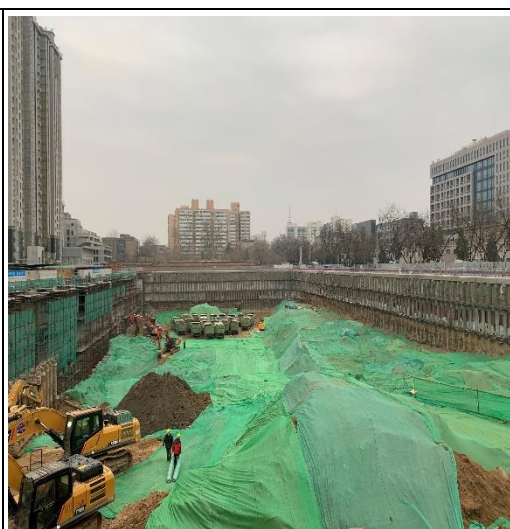
项目临时土存放、苫盖
