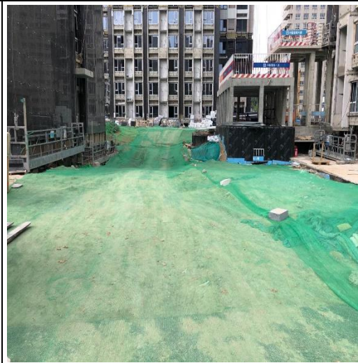
建筑物工程区临时苫盖 2#
