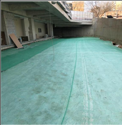
建筑物工程区临时苫盖 1#
